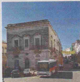
EX CINEMA Prima dell'inizio dei lavori
