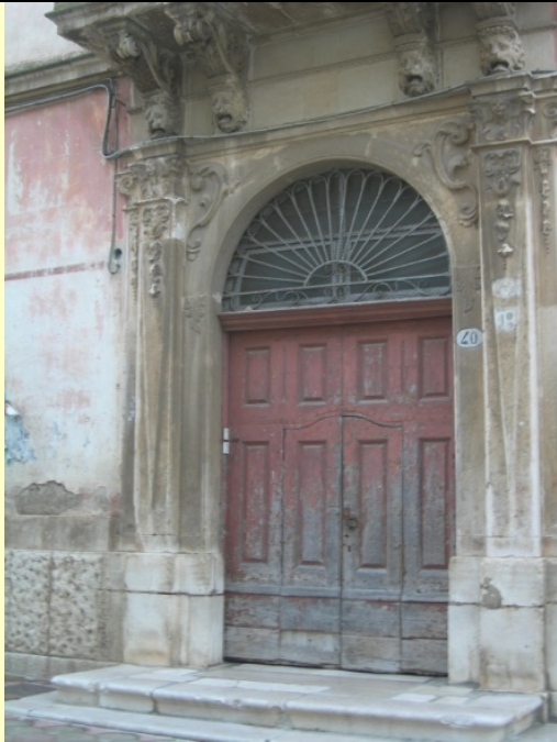
FOTO 1 – Il Portone di Ingresso
