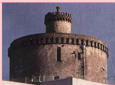
FOTO 2 – La Torre con le sue merlature - particolare
