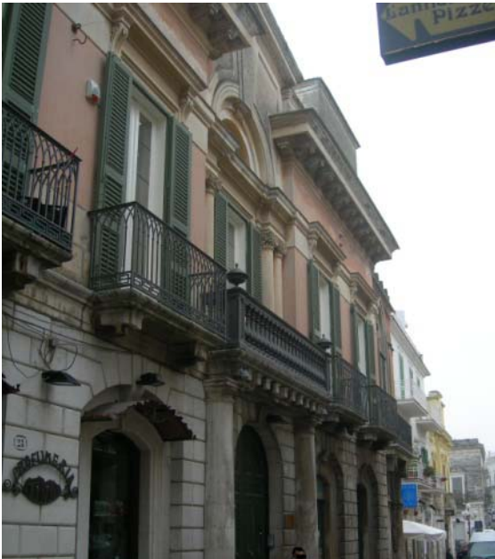
FOTO 1 – palazzo Corsi – Facciata su Corso De Gasperi
