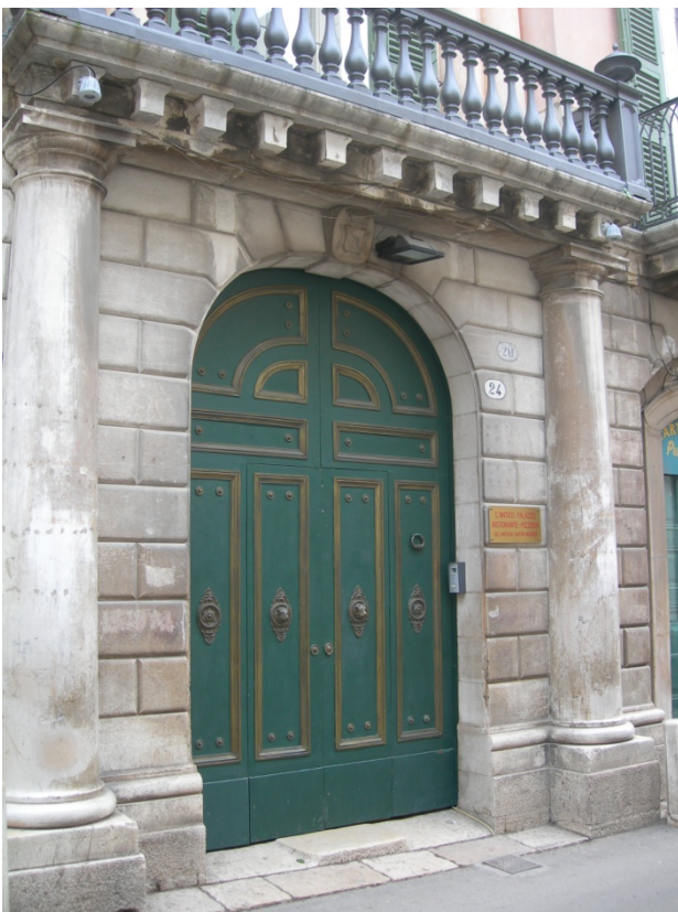
FOTO 3 – Il portone di ingresso
