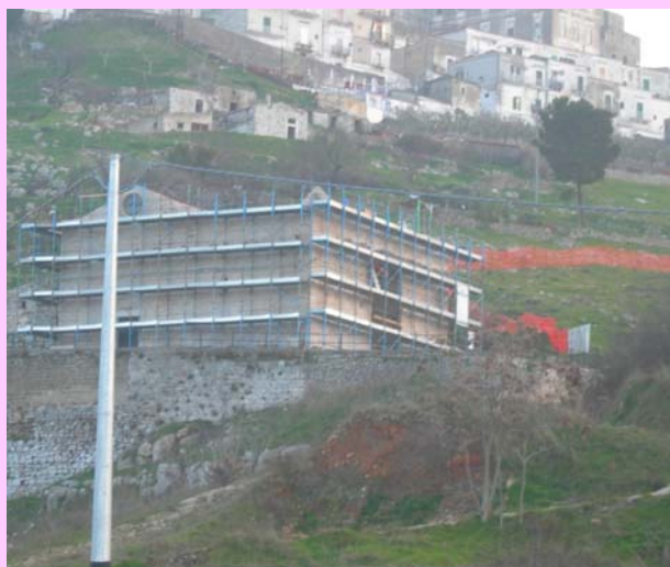
FOTO 1 – ↑ il cantiere che attualmente interessa la Chiesa della Madonna della Croce
